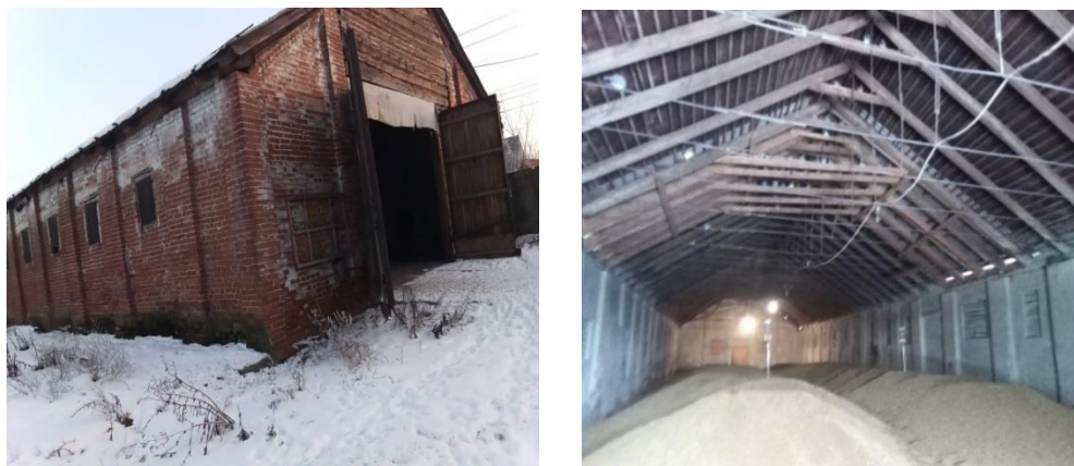
Рисунок 1. Кирпичный склад с зерном ячменя и термоштангами
