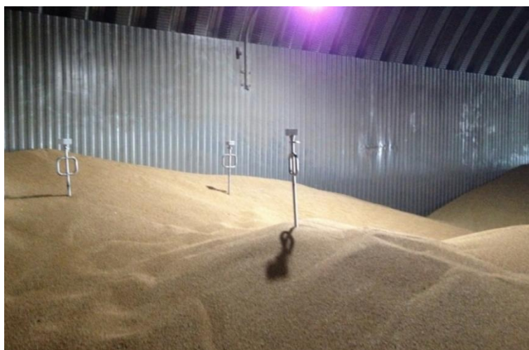
Рисунок 3. Металлический ангар с термоштангами в ворохах зерна пшеницы
