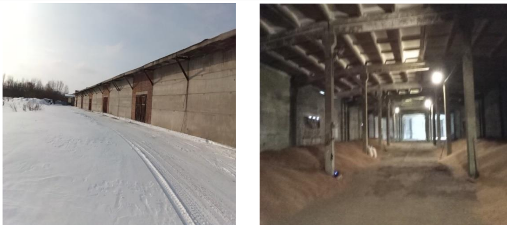
Рисунок 2. Железобетонный склад с зерном пшеницы и термоштангами
