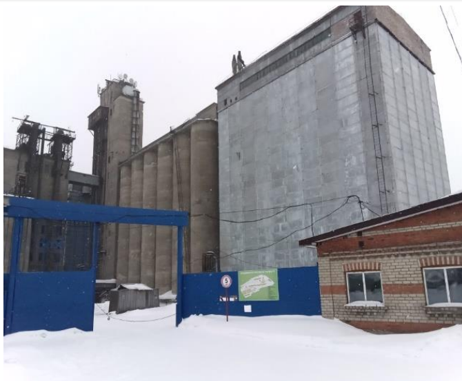
Рисунок 5. Элеватор с железобетонными силосами
